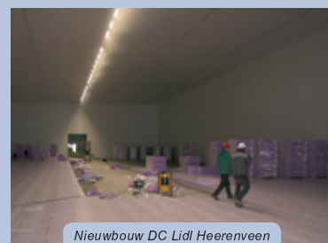
Nieuwbouw DC Lidl Heerenveen
