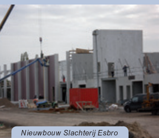
Nieuwbouw Slachterij Esbro in Wehl
